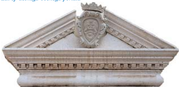
Zatrej desnega bočnega portala
